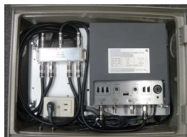
狭いBOX内の接続
